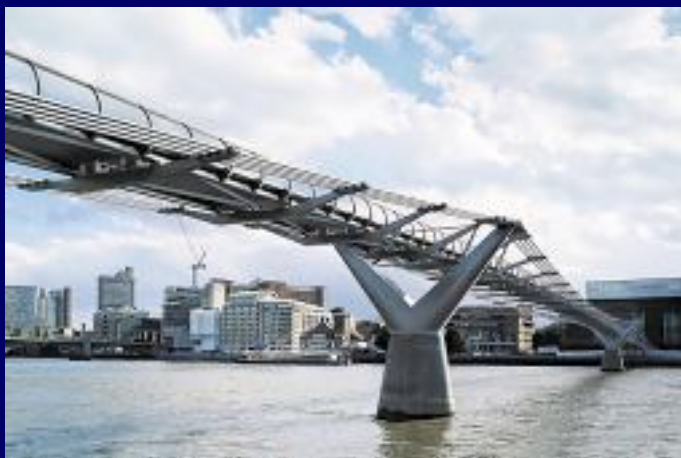
Millennium Bridge, Londres - 2000
