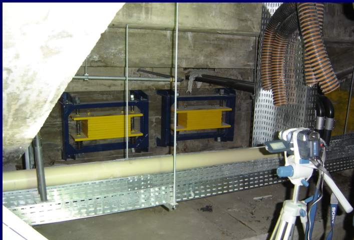
Detalhe de um par dos 36 ADS instalados no Interior das estruturas das arquibancadas
