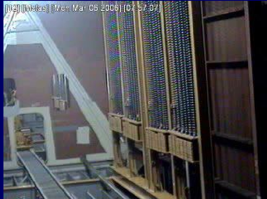
Imagens da câmera de vídeo instalada dentro de uma das duas vigas celulares
